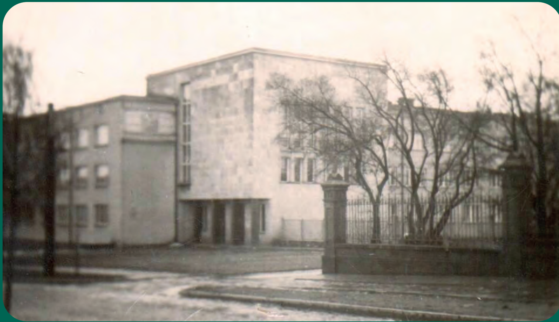
1938 r. Budowa siedziby Dyrekcji Lasów Państwowych w Radomiu. Zdjęcie ze zbiorów P. Kacprzaka.
